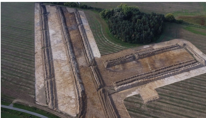
Pohled na skrytou plochu jedné z retenčních nádrží budoucího obchvatu Prahy u Netluk
